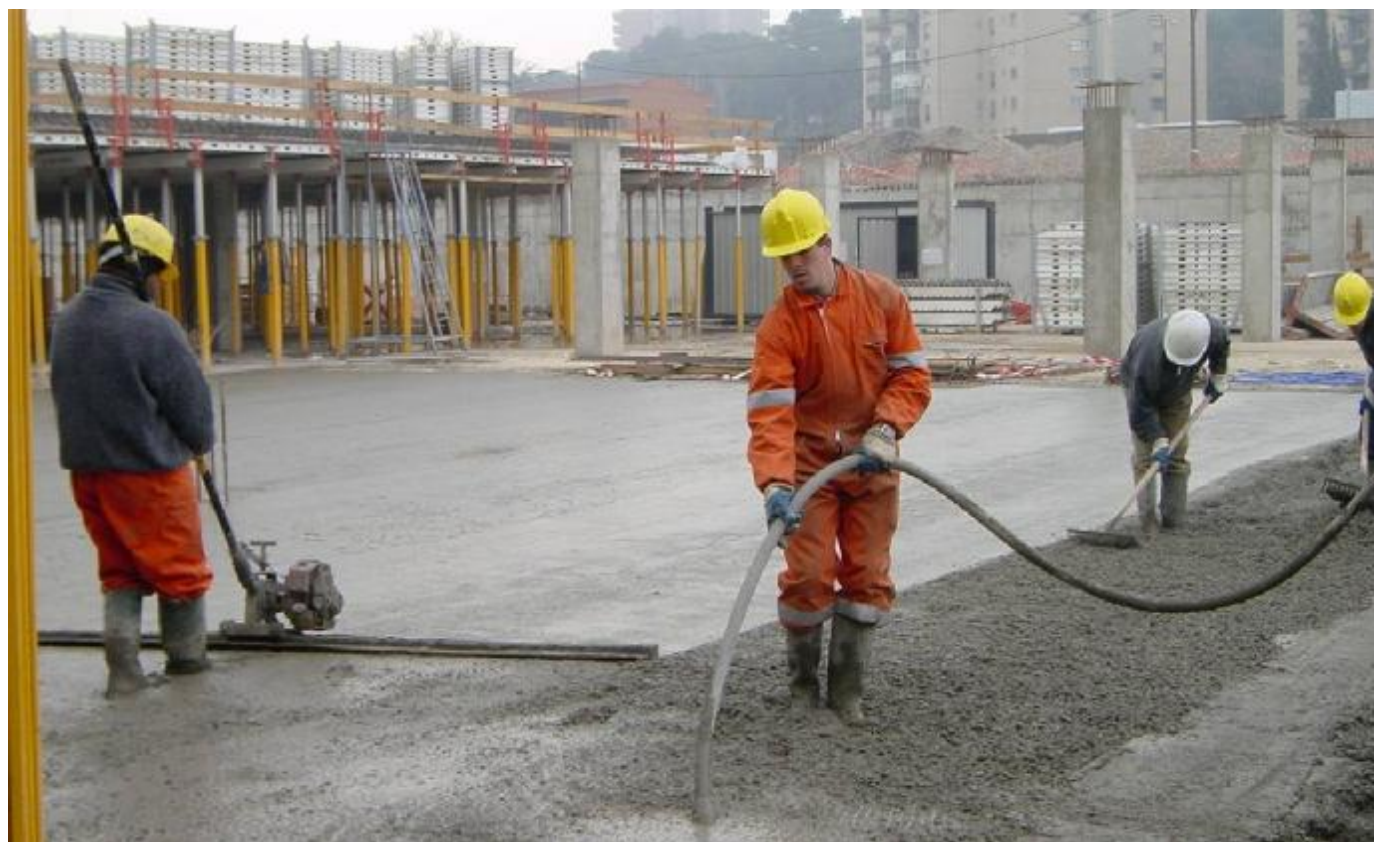
Vibrarea placilor groase de beton cu vibratoare de adancime, urmata de vibrare superficiala si finisare cu rigla vibranta.
